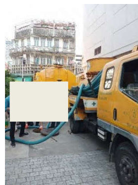
ภาพที่ 2.2-14 การสูบน้ำจากตะกอน จากระบบบำบัดน้ำเสีย
