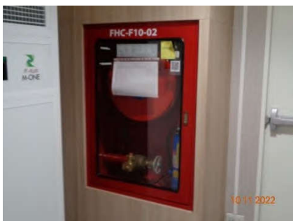
ภาพที่ 2.2-32 ตู้เก็บสายฉีดน้ำดับเพลิง พร้อมอุปกรณ์ (Fire Hose Cabinet : FHC)
